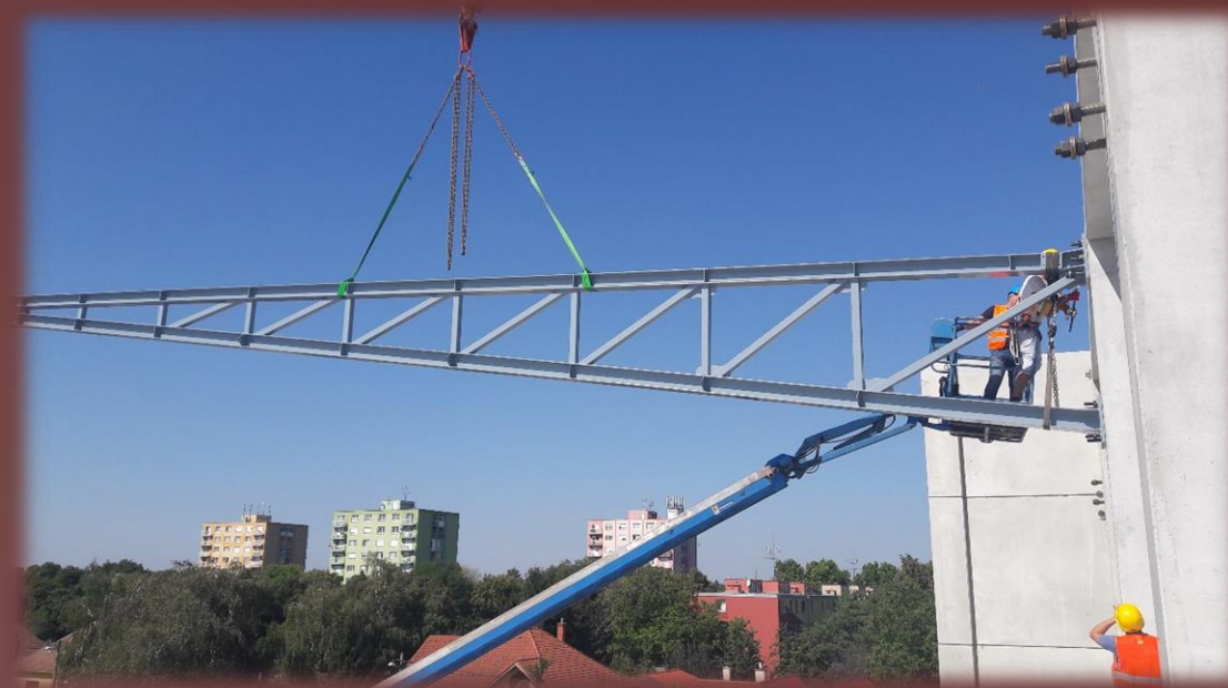
Montáž ocelevej konštrukcie _foto z 2016.09.01
