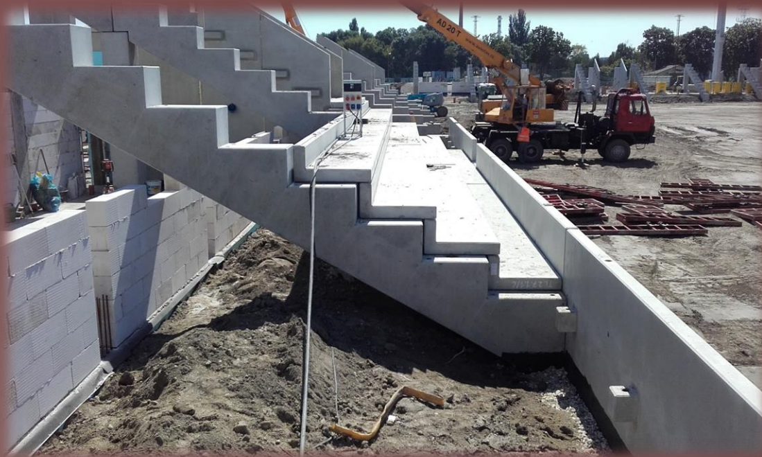
Montáž tribúnových lavíc a spodných stien_foto z 2016.08.04
