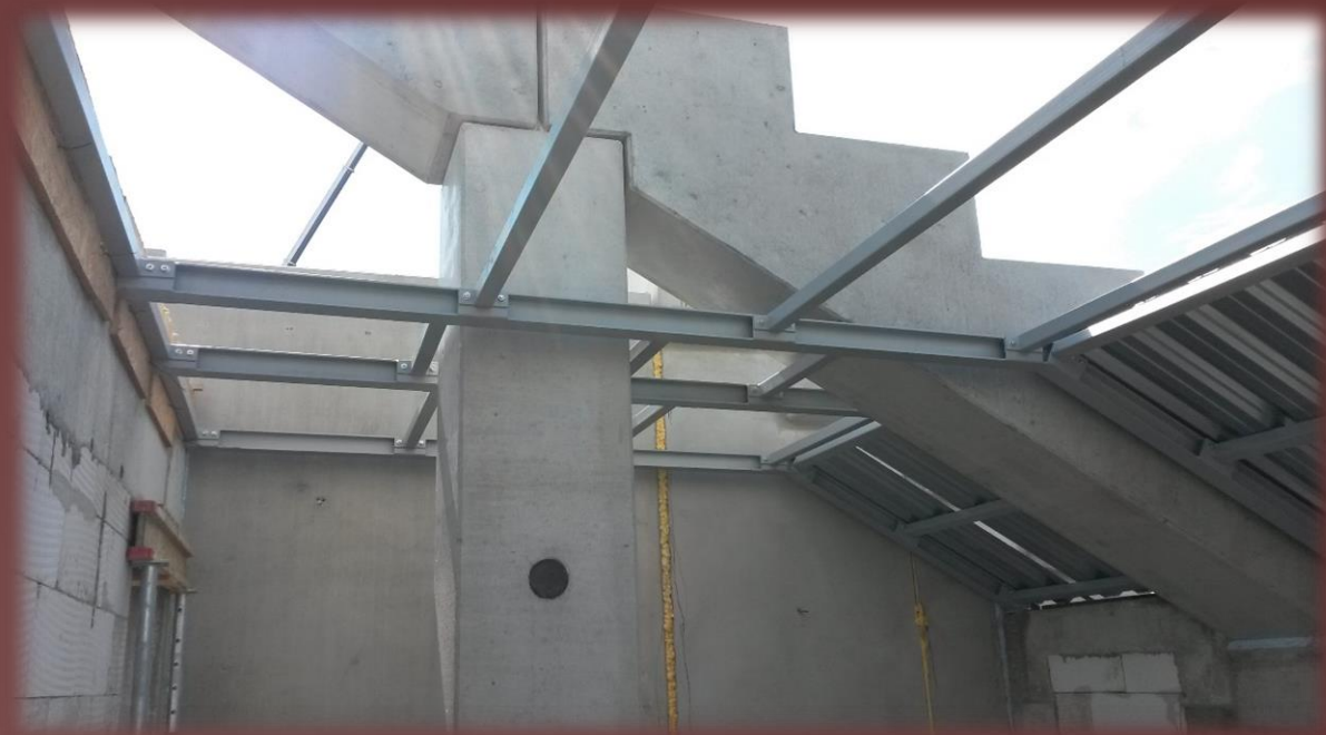
Montáž lavíc, prievlakov a ocelejovej konštrukcie vstavkov_foto z 2016.08.11
